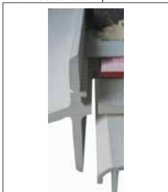
15. Detail montáže profilu H14 a odvodnenia systému pomocou rohože KD 5 a PVC distančného profilu k H14
