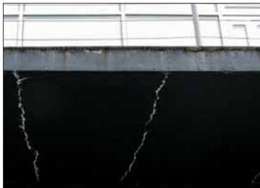
3. Poškodené balkónové teleso
