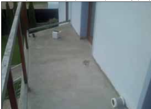
7. Spádový klin z EPS 200 pre prevedenie povrchovej úpravy
