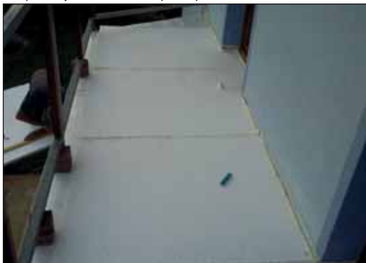
7. Spádový klin z EPS 200 pre prevedenie povrchovej úpravy
